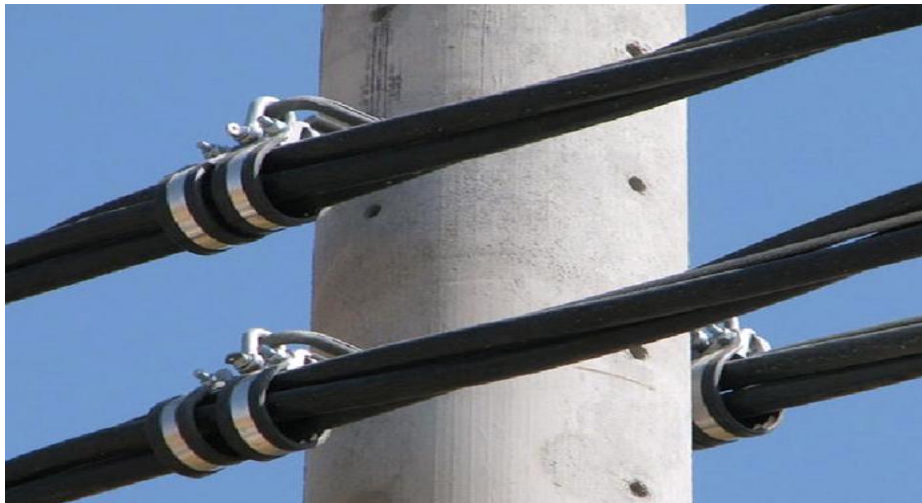
شکل ۲۲: نمای کلمپ آویز فشار متوسط کابل خودنگهدار در شبکه
