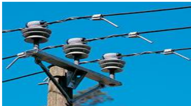
شکل ۲۰: نمای شبکه اجرا شده با هادی روکشدار
