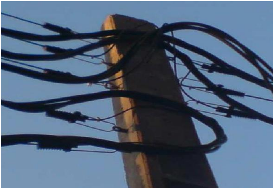
شکل ۲۶: نمای کلمپ انتهایی کابل خودنگهدار فشار متوسط
