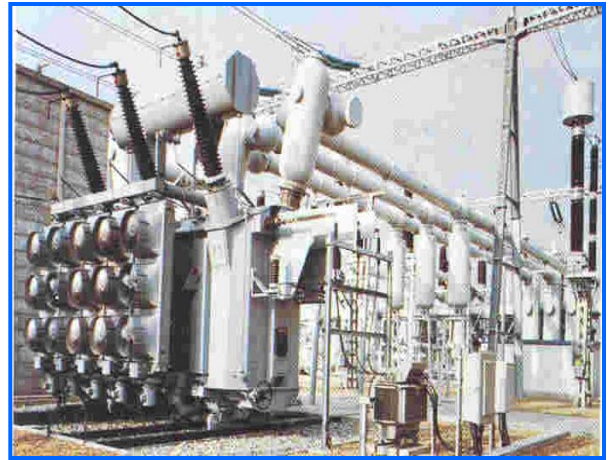
شکل ۸-۱ اتوترانسفورماتور قدرت فشارقوی با توان ۶۰۰ MVA و ولتاژ KV ۲۳۰ / ۴۰۰
