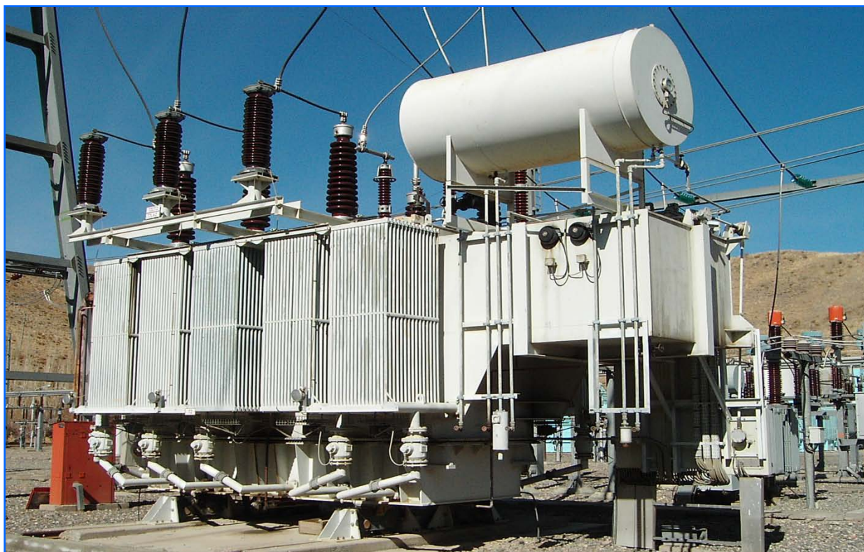
شکل ۱۱-۱ اتو ترانسفورماتور با قدرت نامی 160 MVA با ولتاژ KV ۲۰ / ۶۳ / ۱۳۲
